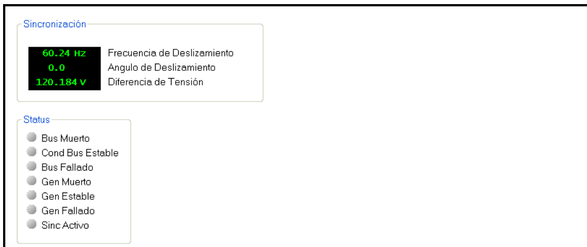
Figura 13-8. Medición de Valores Primarios de la Sincronización
